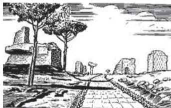
Дорога в Италии, построенная в 312 году до н. э. и сохранившаяся до наших дней
