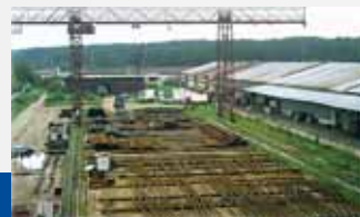
Рельсовая площадка в г. Березовске
