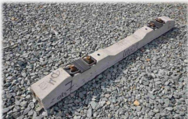
Шпалы железобетонные предварительно напряженные под скрепление ЖБР-65 (нераздельное с болтовым прикреплением рельса к шпале)
