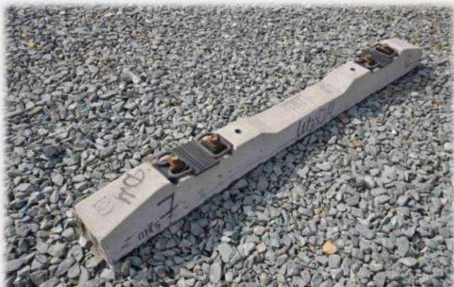
Шпалы железобетонные предварительно напряженные трехниточного совмещенного пути под скрепление ЖБР-65 (Для Сахалинской ж.д. Применяются с целью перехода с узкой колеи 1067 на нормальную 1520)
