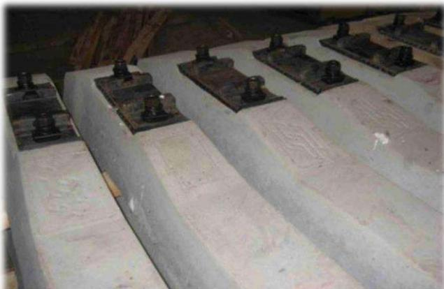
Шпалы железобетонные предварительно напряженные под скрепление КБ65 (раздельное клеммно-болтовое с болтовым прикреплением подкладки к шпале и клеммно-болтовым прикреплением рельса к подкладке)
