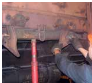
Поджатие люка и вставка уравнивающих прокладок
