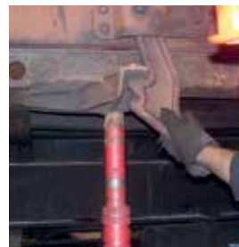
Правка угольника и закрытие замков
