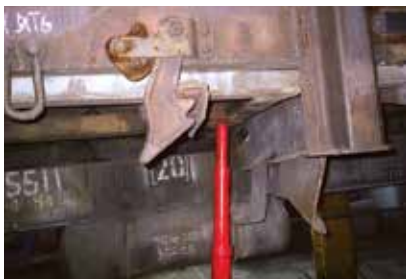
Поджатие центрального ребра жесткости люка для проведения сварочных работ
