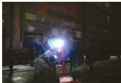
Поджатие дефектного места и проведение сварочных работ
